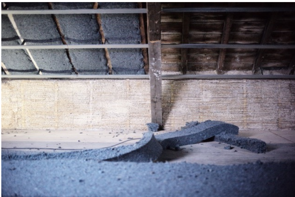
Laine de coton Métisse sous les rempants par Le Relais (Emmaüs).
